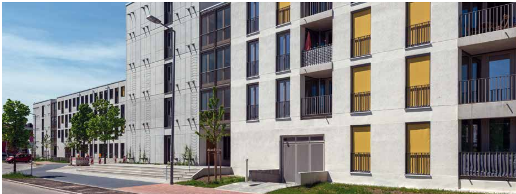
Bildnachweis: Mehrgenerationenhaus mit 115 Wohnungen, 85356 Freising / Lerchenfeld Architekt: EAP Architekten München Aussenwand UNIPOR WS09 / WS10 CORISO 42,5 cm
